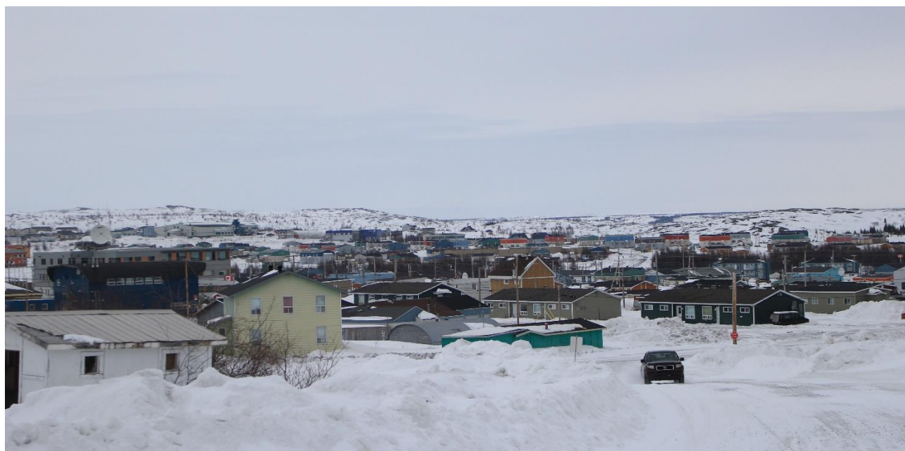
Les coûts de construction et d'entretien des maisons dans des endroits tels que Kuujuaq, au Québec, comme l'illustre la photo ci-dessus, sont beaucoup plus élevés que dans le Sud du Canada.
